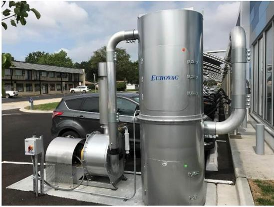
Sistema Eurovac III 10HP - 75HP Productores de aspiración de turbina y separadores de filtro de bolsa
