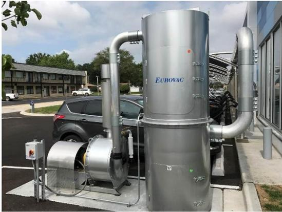
*Système Eurovac III 10HP - 75HP Aspirateurs à turbine et séparateurs à sacs filtrants*
