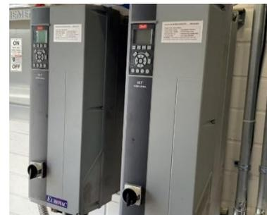
Entraînements à fréquence variable (VFD's)
