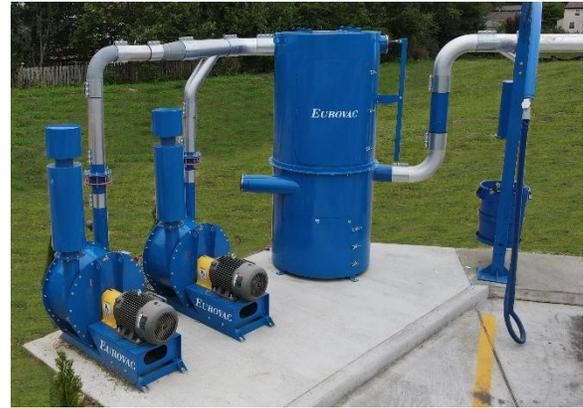
*Système Eurovac III à double pompe 10HP - 75HP (x 2) Turbines et séparateurs à sacs filtrants*
